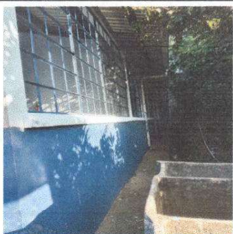
Foto No. 7 Reparación de repello y cernido de paredes.
