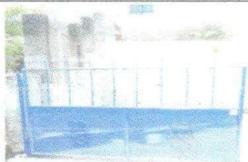
Foto No. 1 Sustitución de porton de salida de emergencia, medida 4.90 mts.
