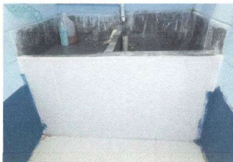
foto 9 sustitucion de pila, sanitarios
