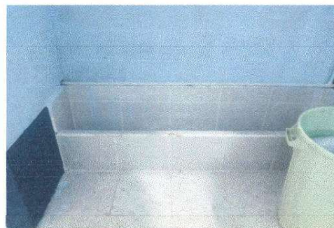
foto 10 sustitucion de migitorio, sanitarios
