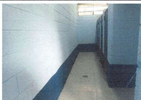
foto 8 sustitucion de piso de torta de concreto por piso ceramico
