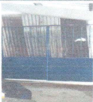
Foto No. 1 Sustitución de porton de salida de emergencia, medida 4.90 mts.
